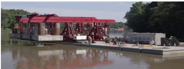
IMG 5 - Hoisted Precast Riser
