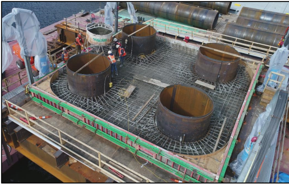
Photo 13 - Intermediate Concrete Brace Pour
